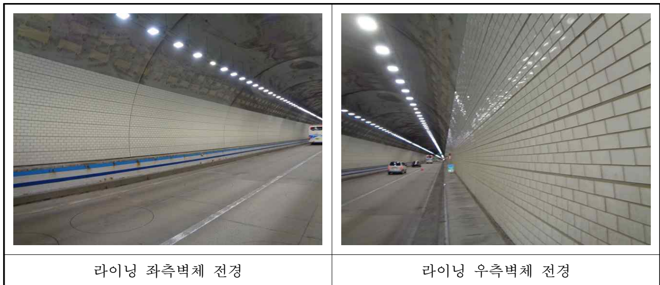
【사진 3.5】 터널 라이닝 측벽부 전경
