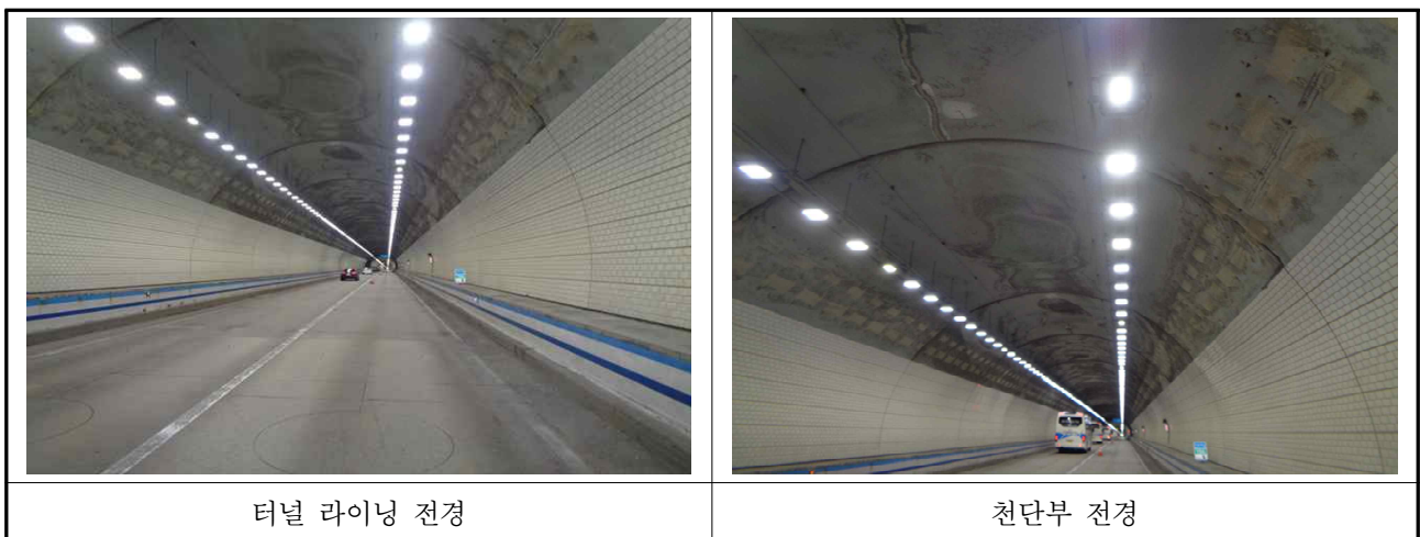
【사진 3.3】 터널 라이닝 천단부 전경
