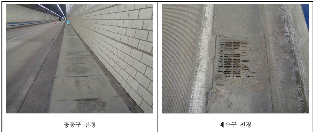
【사진 3.11】 공동구 및 측구(배수로) 전경
