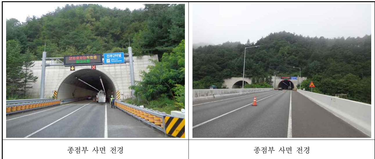
【사진 3.9】 사면 시·중점부 전경
