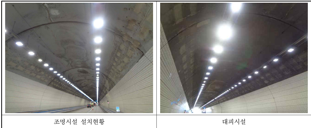
【사진 3.15】 기타 부속시설 전경(계속)
